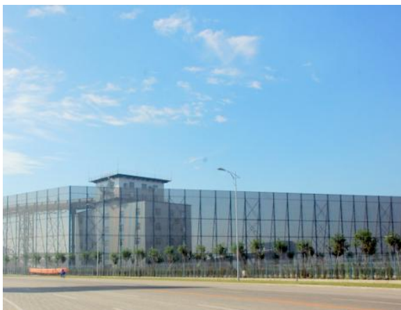
某港口防风网设置
